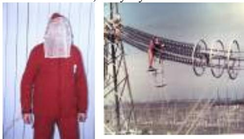
**Рис.2 – Защитный комплект технического персонала в электроэнергетике**
