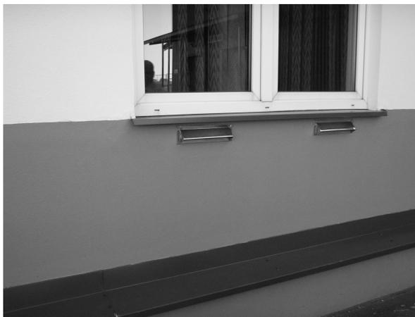
Рис. 2 . Загальний вигляд місцевих систем припливної вентиляції
